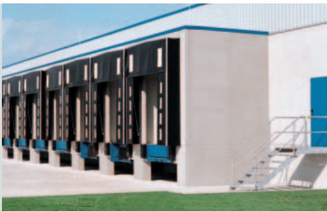
Voorzetsluizen in geprefabriceerd beton
